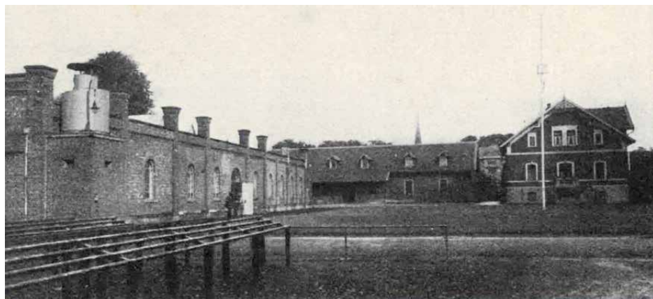
Weberei (links) und Verwaltung (rechts)
