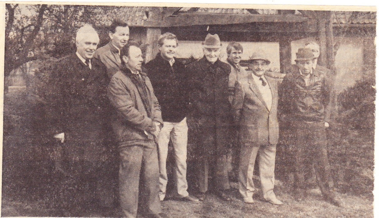
Am Oesterweger Glockenturm sind Renovierungsarbeiten notwendig. Die „Glockenbauern“, die aus langer Tradition für die Glocke verantwortlich sind, trafen sich zu Vorbesprechungen. Fotos: Bureau
